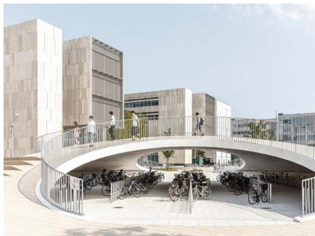
Ref: Fietsenstalling onder artificiële heuvel - COBE
