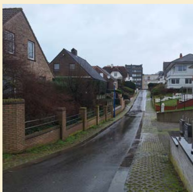
Het publiek domein in de groene binnenstraten bestaat vaak enkel een uit rijbaan met gras(dal)stroken om te parkeren
